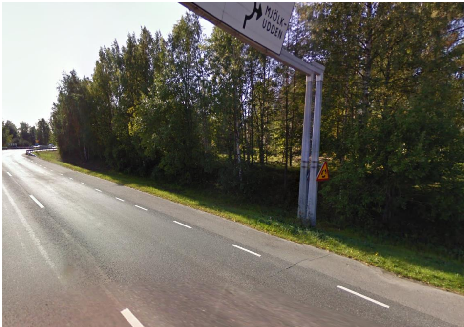
Figur 10. Bild över dike längs Bodenvägen mot planområdet.
