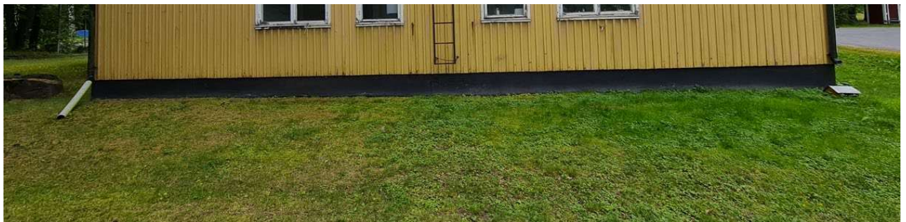
Bild 5 Mark utanför byggnad, Sandgatan 6.
