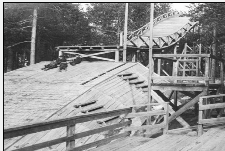
Både hopptorn och underbacke var byggda av trä. Underbacken hade trappor så att de som önskade kunde nöja sig med att endast åka där.
