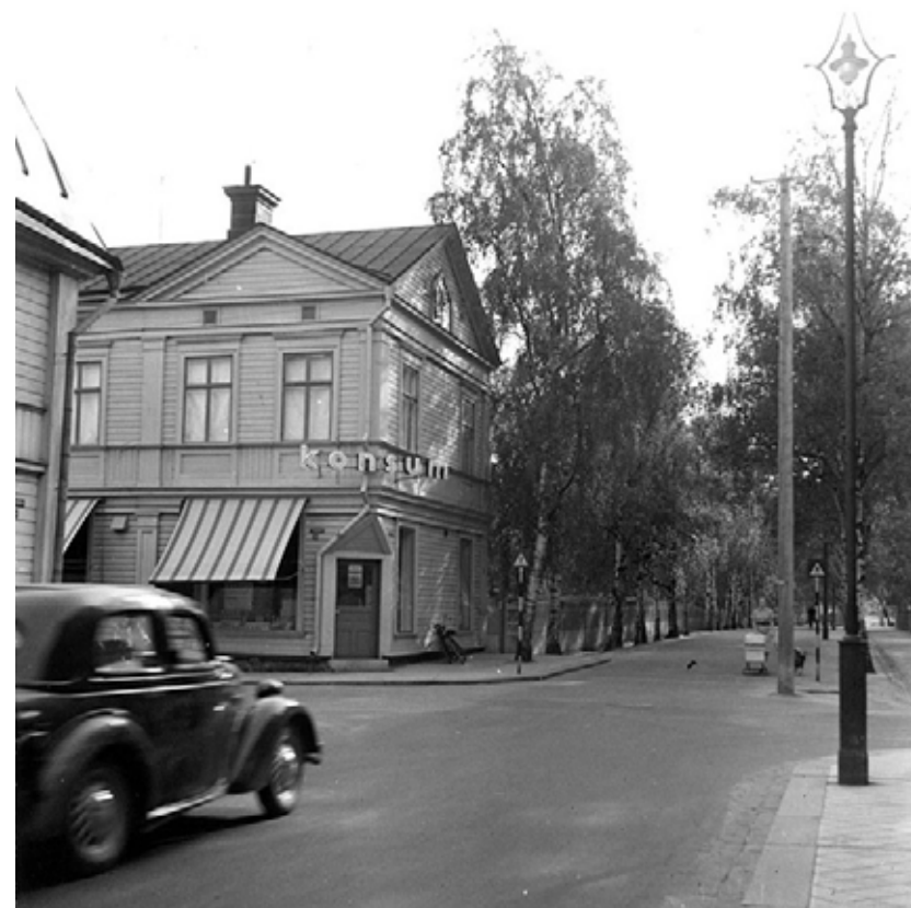
Den förmodligen vanligaste gatubeläggningen under lång tid i Luleå centrum: asfalt på körytorna, en rännsten i tre raders storgatsten som möter en påkostad ramsten i granit som avslutar trottoaren. Trottoaren är belagd med betongplattor lagda diagonalt. Bilden visar Storgatan vid Tullgatan år 1941. Foto: Helmer Widlund, stadsarkivet.
