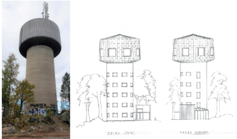
Figur 2. Befintligt vattentorn (t.v.) och illustration som visar möjliga exteriöra ändringar av tornet såsom tillbyggnad av entré (t.h). Illustration: Tage Isaksson Arkitektkontor AB.
