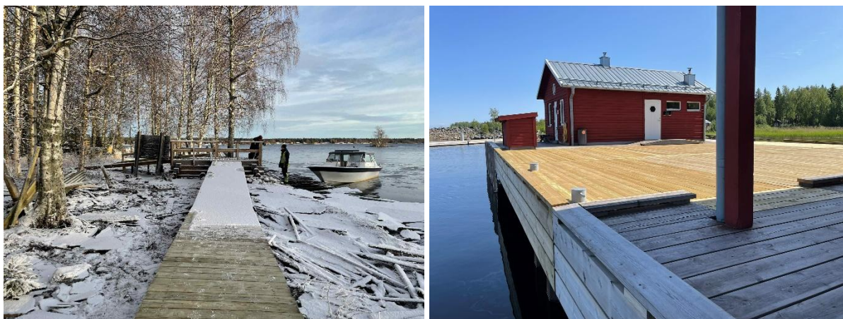
Figur 13. Spången längs stranden på Altappen blev klar under hösten. Det som tidigare var ett "hål" i Junköns brygga har byggts igen och blivit ett stort trädäck.
